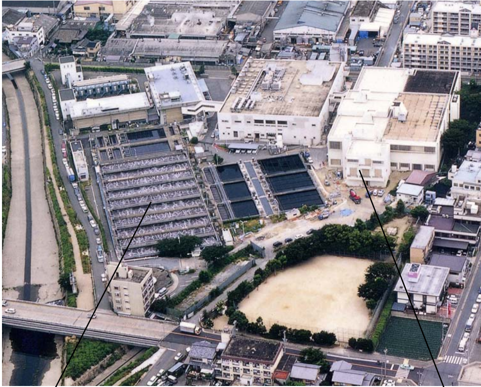
吉祥院水環境保全センター全景
