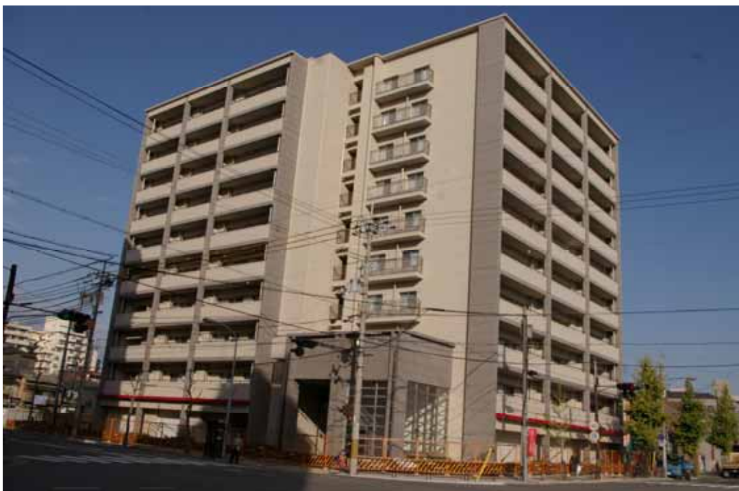
崇仁市営住宅 51 棟完成写真 (平成 17 年 11 月竣工)
