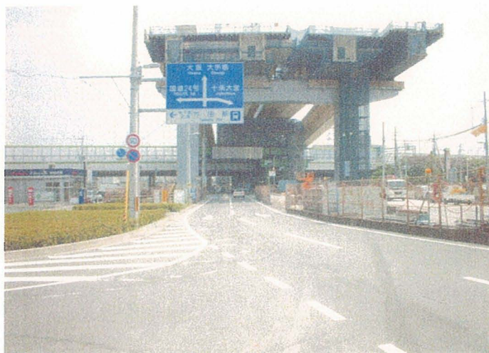
①広路4（油小路通）南行車線（完成）
