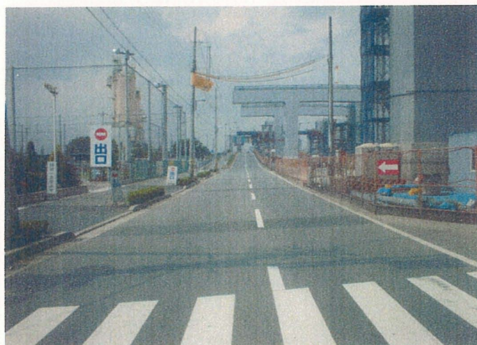
②広路4（油小路通）北行車線（完成）
