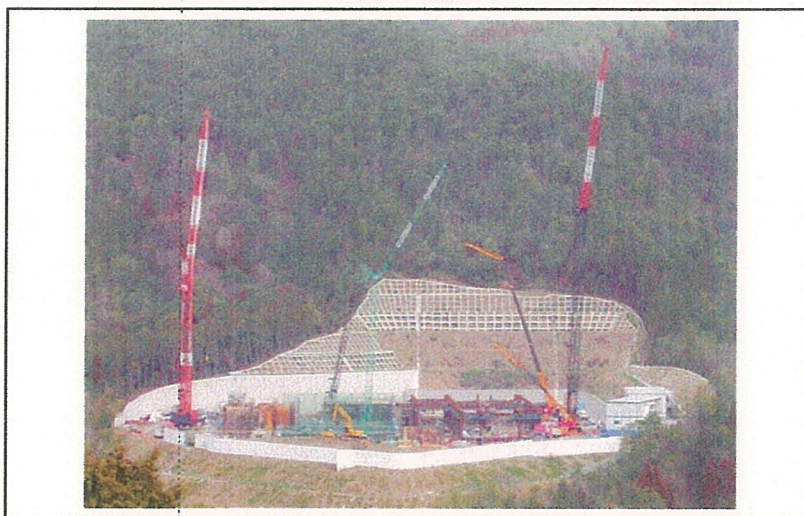
〔工事区域全景戸山より〕
