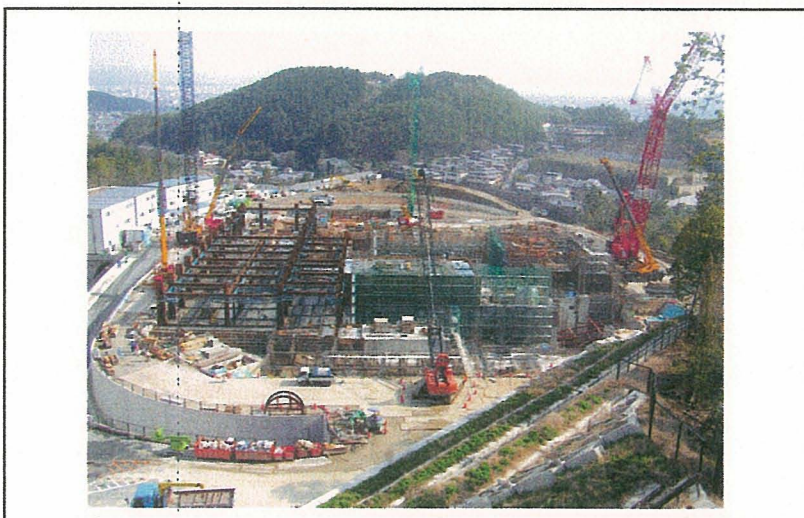
〔現場全景北面より〕
