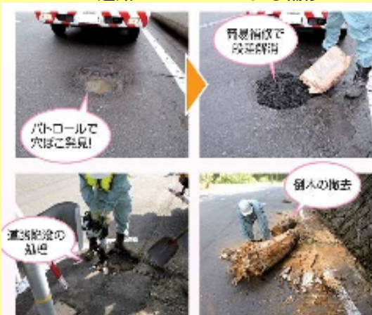
道路パトロールによる補修
