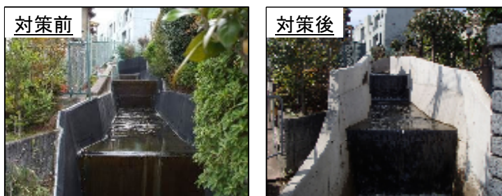
荒木川（平成 27 年 3 月 対策完了）（西京区川島権田町）
