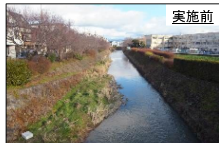
河川維持補修 浚渫・除草 (有栖川)
