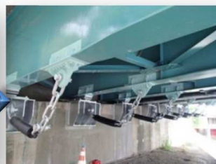
三栖高架橋 対策後
