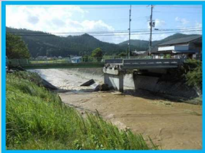
鳴瀧橋 (平成25年9月16日 被災直後)
