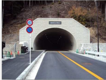
国道 162 号（京北トンネル）
