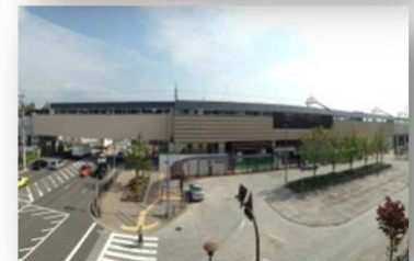
阪急京都線連続立体交差化事業
