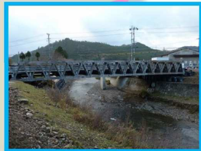
鳴瀧橋(仮橋) (平成25年12月20日 仮橋完成)
