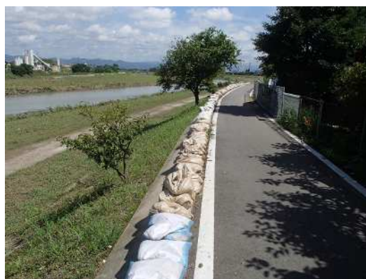
下鳥羽水防団による土のう設置
