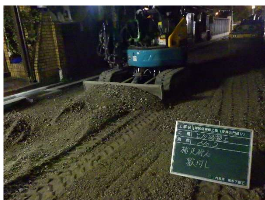
路盤材(砕石)の敷き均し (バックホウ使用)
