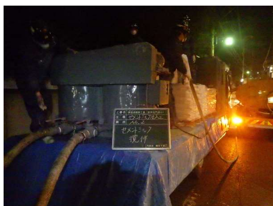
セメントミルク攪拌状況
