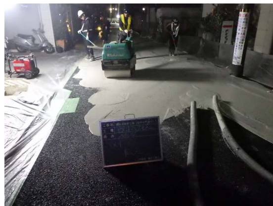
セメントミルク浸透工 保水性ミルクを使用
