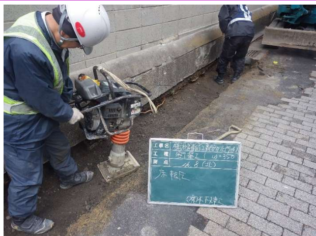
新しい街渠工の施工
