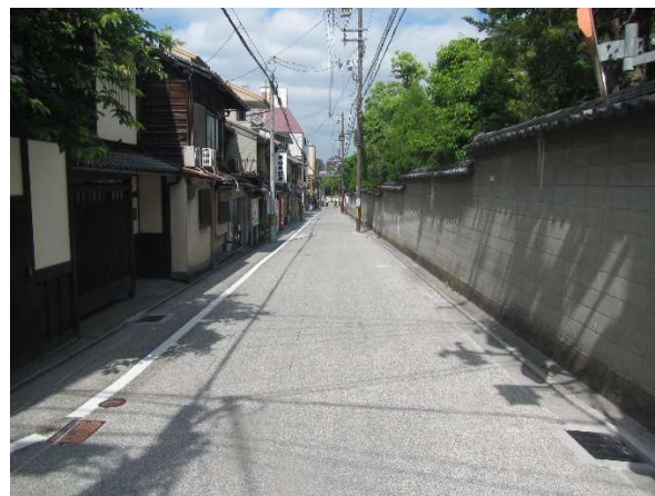
工事完了 (中間地点)
