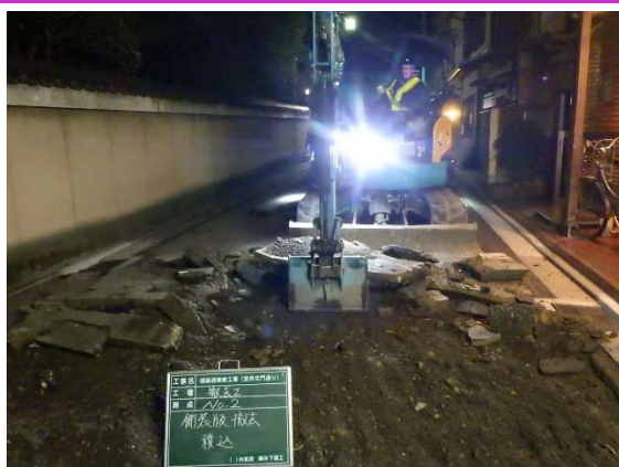
夜間工事の状況 既設の舗装版撤去
