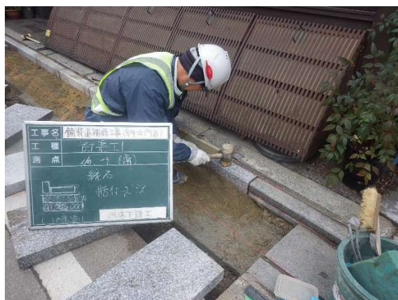
街渠工の施工（御影石）
