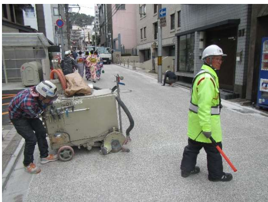
デザインカッター工の施工状況
