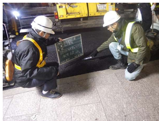
舗装工の施工管理 (アスファルト合材の温度測定)
