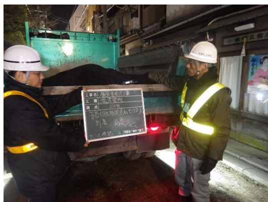
舗装工の施工管理 (アスファルト合材の温度測定)
