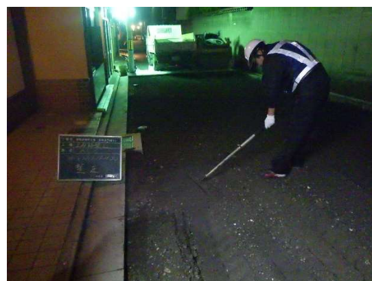
路盤材(砕石)の敷き均し
