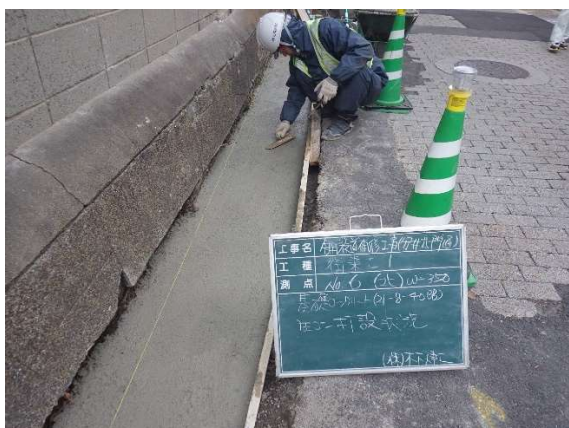
街渠工の施工（御影石）
