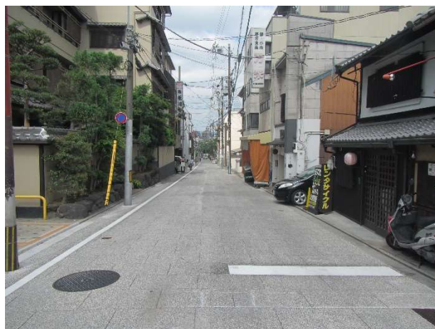
工事完了 (東大路通から西側を望む)
