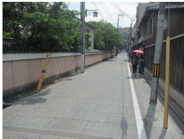
工事完了 (花見小路から東側を望む)
