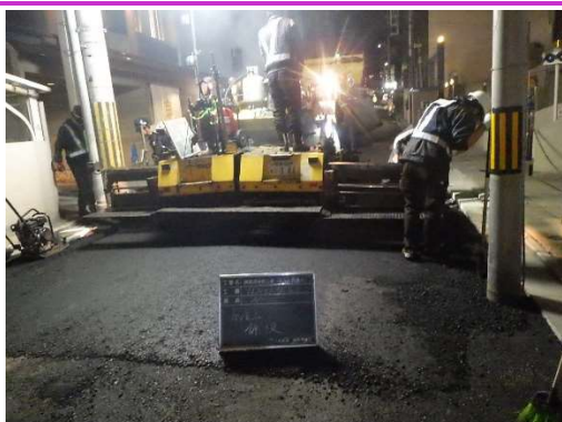
舗装工事(基層工) アスファルト合材の舗設
