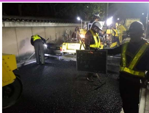
舗装工事(表層工) アスファルトフィニッシャー使用
