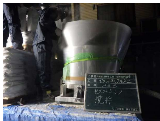
セメントミルク攪拌状況
