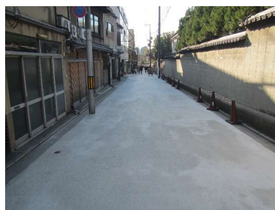
セメントミルク浸透が完了した状況
