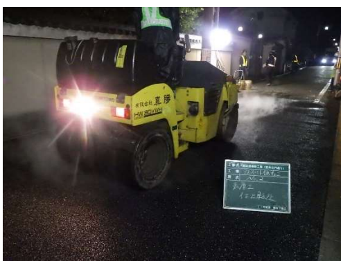
アスファルト合材の転圧状況 振動ローラー使用
