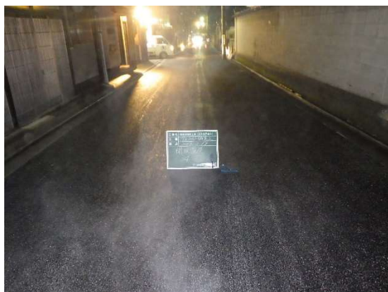
舗装工事(表層工) 完了状況
