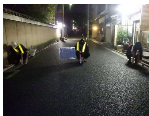
舗装工の施工管理 (高さの測定)
