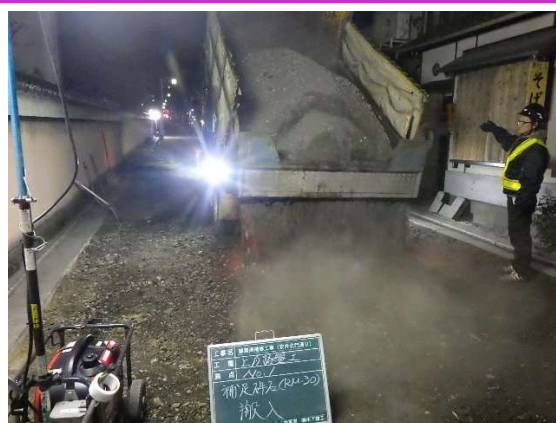
路盤材(砕石)の搬入
