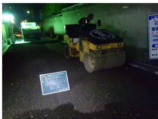
路盤材(砕石)の転圧 (振動ローラー使用)
