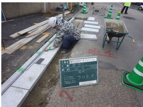
街渠工の施工（御影石）
