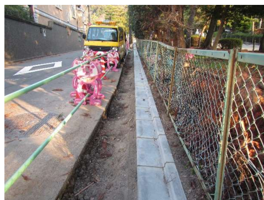
L 型側溝設置完了
