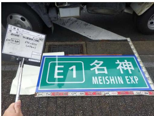
使用材料(当て板補修板 0.62m\*1.45m)
