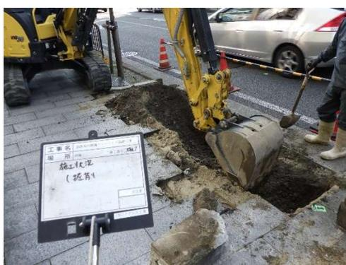
新しい標識柱の基礎を施工
