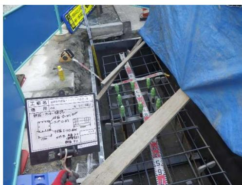
基礎の型枠・鉄筋・アンカーボルトの
