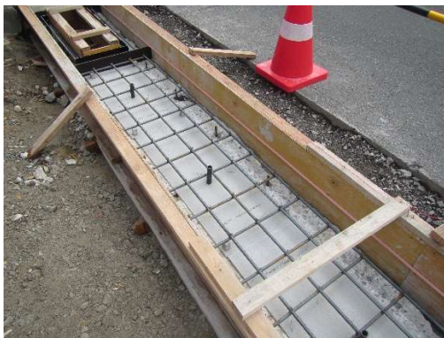
側溝の蓋を補修 蓋部分の配筋を行う。
