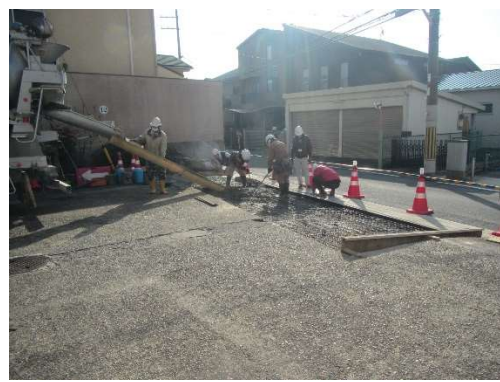
コンクリートの打設 工事影響部のすりつけを行う。
