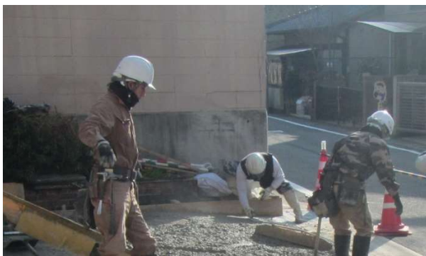
コンクリートの打設 工事影響部のすりつけを行う。
