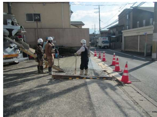
コンクリートの打設 工事影響部のすりつけを行う。
