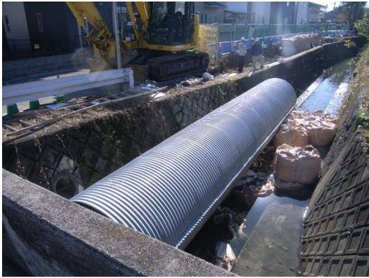
作業ヤード造成のために、仮水路(コルゲート管)を設置
