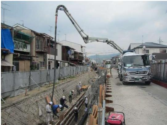
張りコンクリートのコンクリート打設
