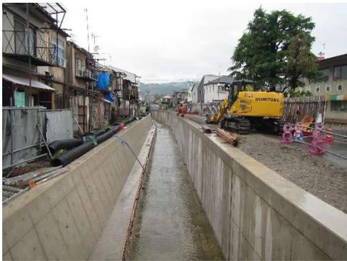
張りコンクリートの施工完了
