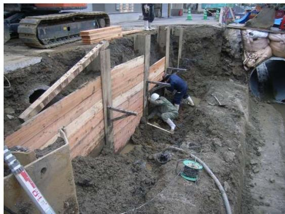
橋台があった部分を掘削するため、土留め矢板を設置する
