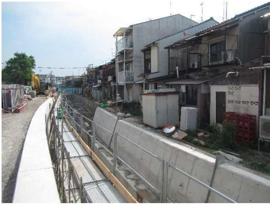
右岸側張りコンクリートの施工完了
