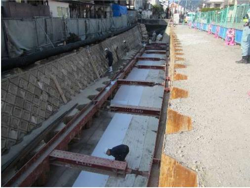
河床コンクリートを打設完了。
