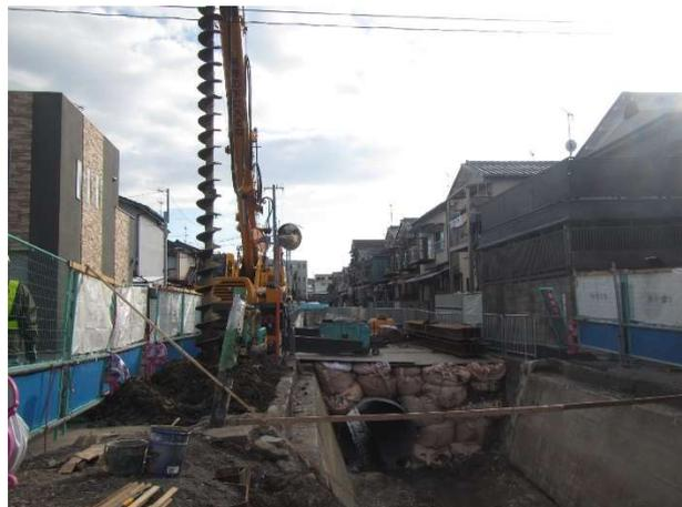
橋台を撤去する前に、土留め用のH型鋼を地中に設置する。オーガ(ドリル)を使用して掘削する。
