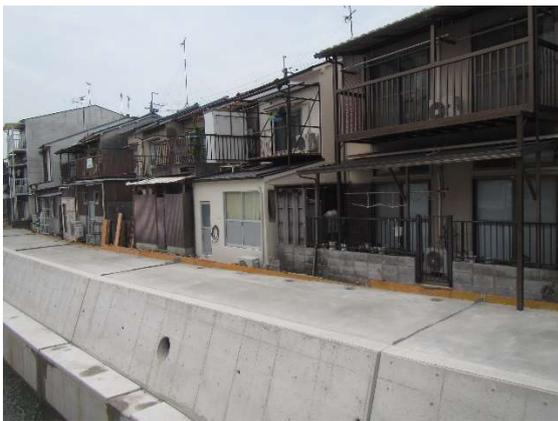
管理用通路の土間コンクリートを打設完了
