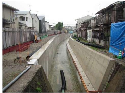
張りコンクリートの施工完了
