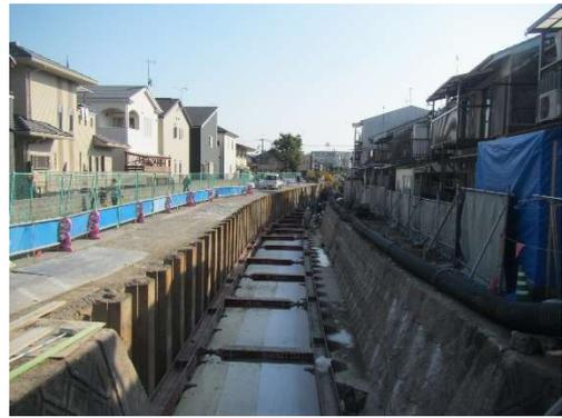
河床コンクリートを打設完了。
