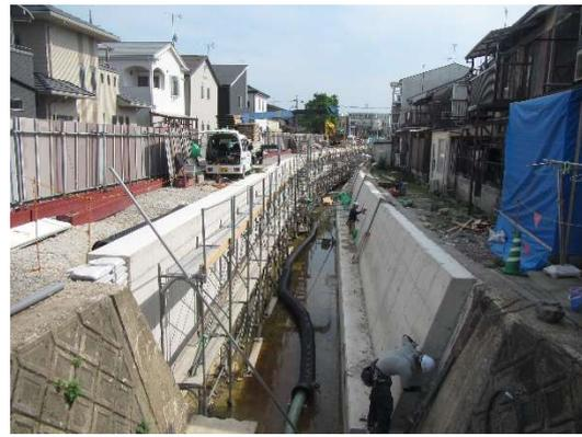
張りコンクリートの施工完了
