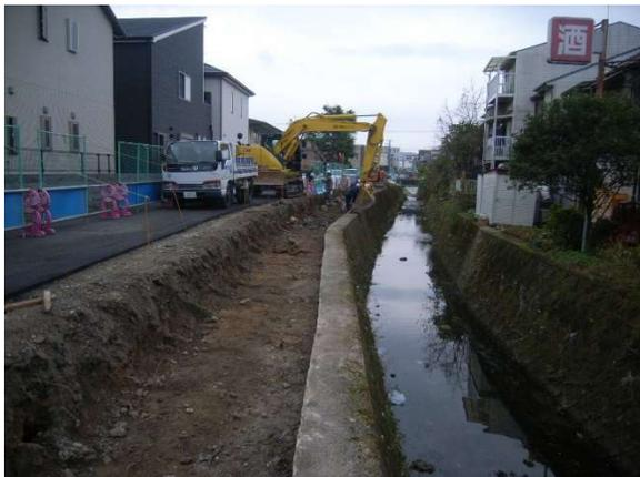
鋼矢板を圧入するための重機を設置できるよう掘削を行う。
