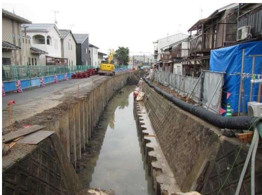
鋼矢板の圧入が完了後，川底を掘削した状況（1次掘削）
