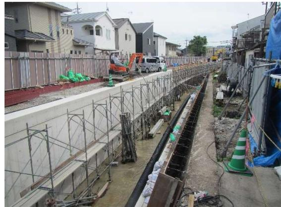
左岸側張りコンクリートの施工完了
