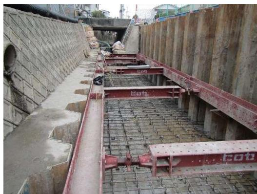
河床コンクリートの鉄筋を組立
