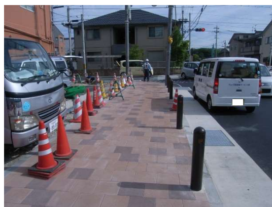
新しい歩道のブロックが設置完了
