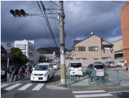
工事前 (交差点南東側より)
