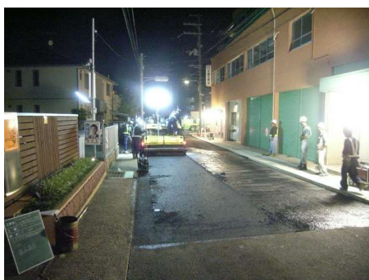
新しいアスファルト合材をアスファルトフィニッシャーを使用して敷きならす作業
