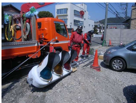
信号機を取替え作業
