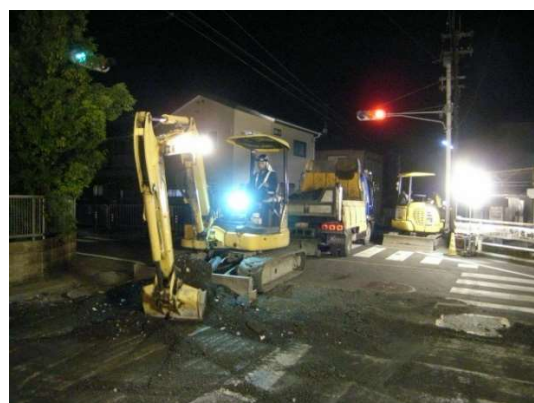
既設のアスファルト舗装を撤去
