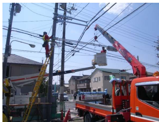
信号機を取替え作業
