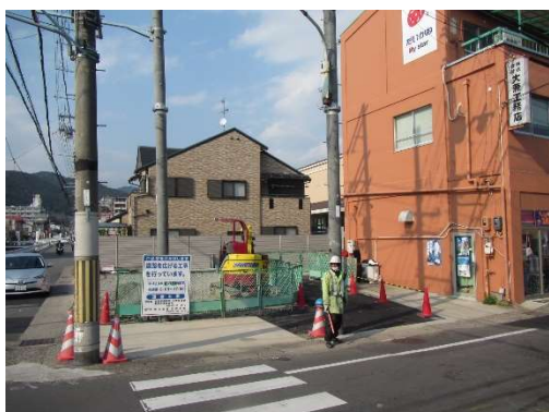
仮歩道の設置
