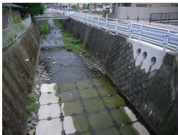
工事完了 (安祥寺川の護岸に新しい道路排水 管を3本設置。川底には、水を受け止 める護床ブロックを設置。)
