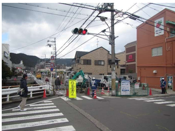
工事の状況 通行止め作業
