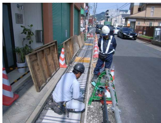
新しい排水側溝の設置作業 蓋部分の鉄筋を組み立てる。
