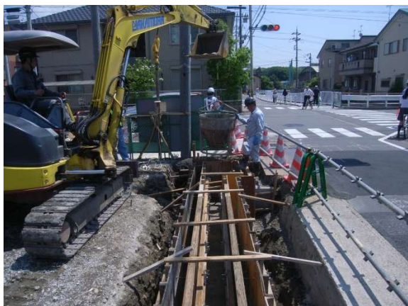
新しい排水側溝の設置作業 型枠にコンクリートを流し込む。
