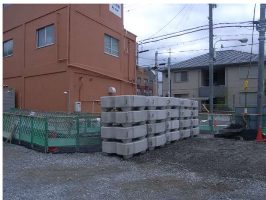
安祥寺川に設置する護床ブロック
