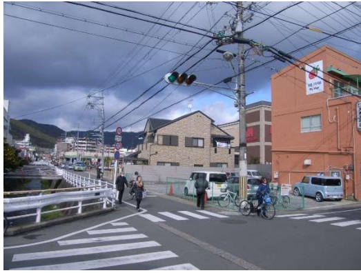
工事前 (交差点南西側より)
