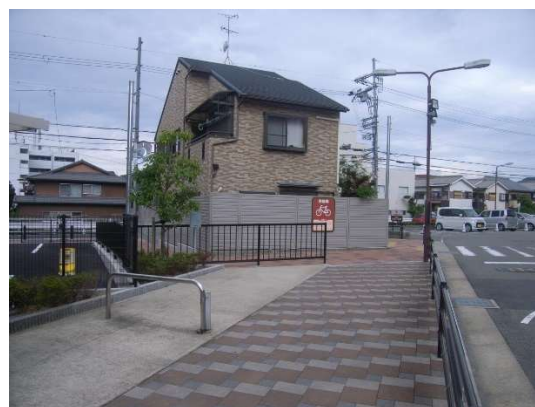
工事完了 (マツヤスーパー敷地内)
