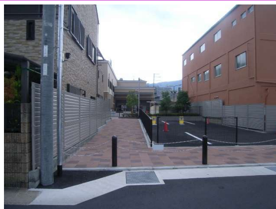
工事完了 (マツヤスーパー側を望む)
