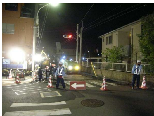
夜間工事の状況 渋谷街道を通行止め
