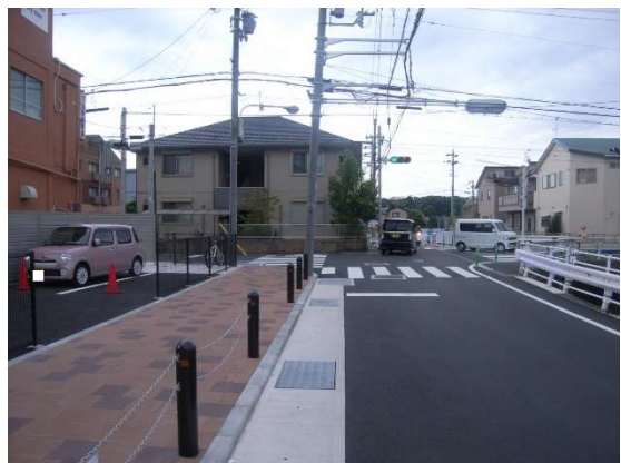
工事完了 (交差点北側より)
