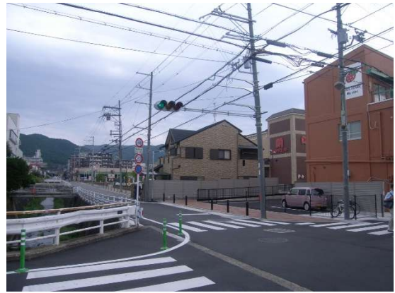
工事完了 (交差点南西側より)
