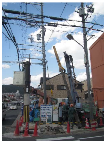
電柱の建替え(関西電力施工)
