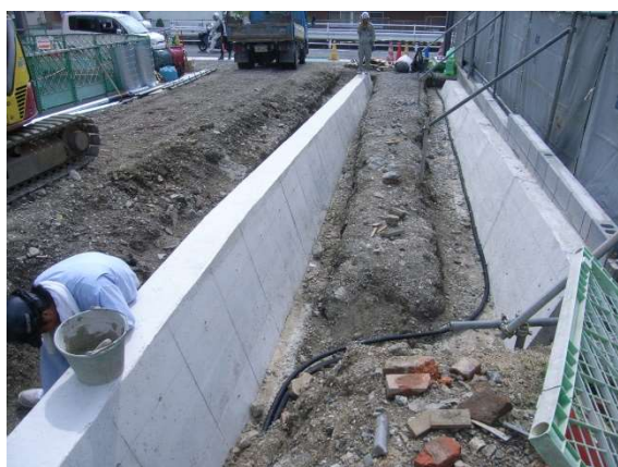
歩道のスロープ°部分 土を受け止めるコンクリート擁壁を設置
