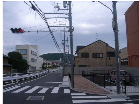
工事完了 (交差点南東側より)
