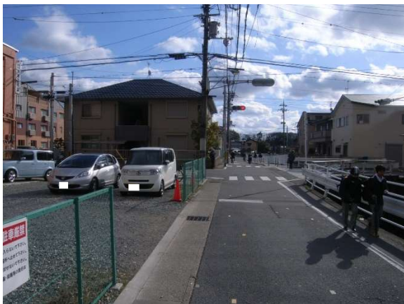
工事前 (交差点北側より)
