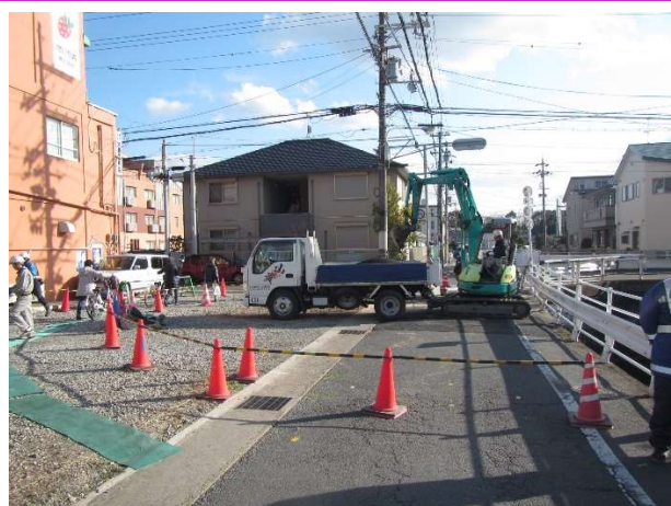
道路を掘削し、地中に埋設されている ガス管などの位置を確認
