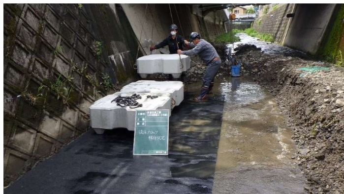
護床ブロックの設置作業
