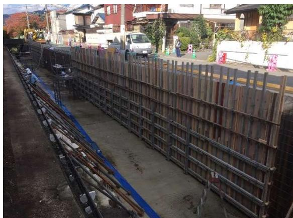
張りコンクリートの型枠を組立完了
