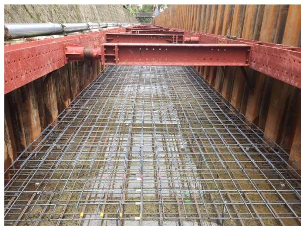
河床コンクリートの鉄筋を組立完了
