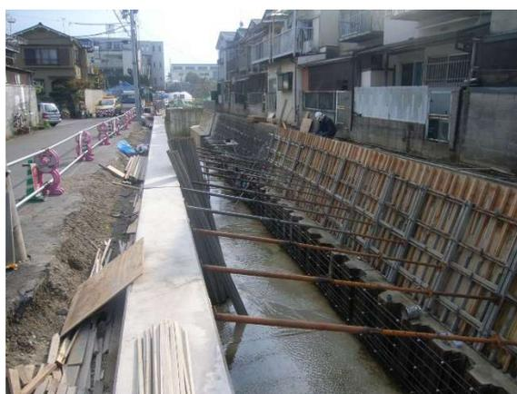
張りコンクリートの型枠を組立完了
