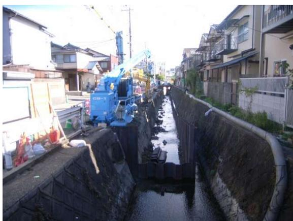
鋼矢板をガス溶断で切断
