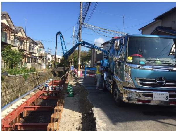
河床コンクリートのコンクリート打設
