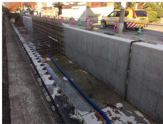
張りコンクリートの型枠を脱型完了
