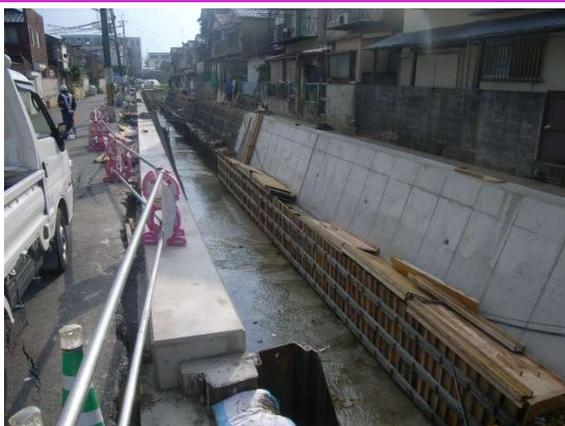
張りコンクリートの型枠を脱型
