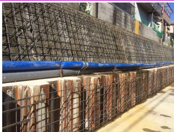
張りコンクリートの鉄筋を組立完了
