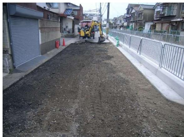
側道のアスファルト舗装を打ち換え。
