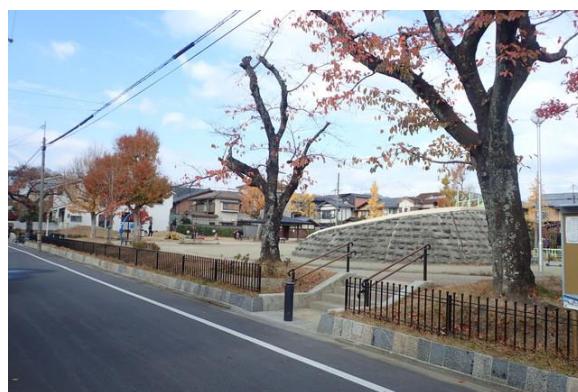
上堀川公園を南側から望む。
