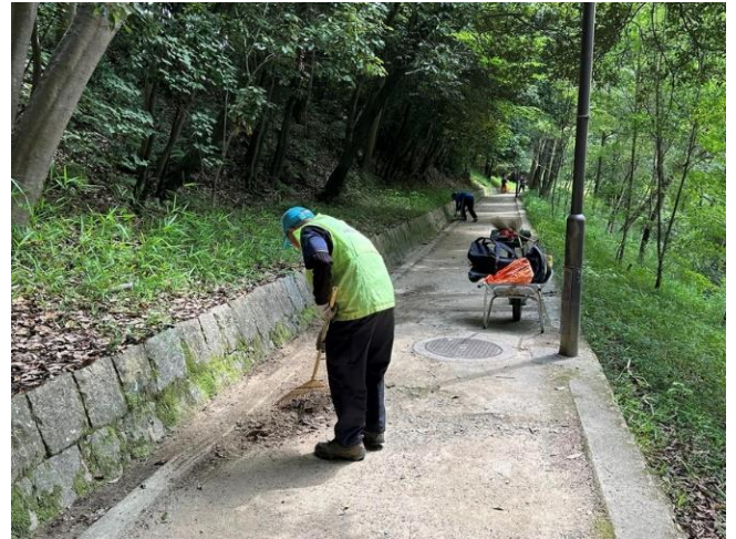
伏見北堀公園外周園路の排水路の泥上げ掃除(6月20日) * みどりの会伏見桃山 提供
