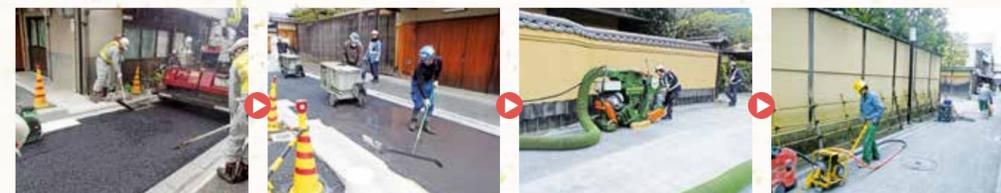
アスファルト舗装      セメントミルク注入      ショットブラスト(表面研磨)      カッター(目地入れ)
