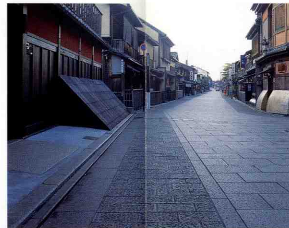
歩行者の安全性を確保する為、歩車道の舗装に用いる石の大きさを換え、歩車道のイメージ的な分離を図った。また、バリアフリーに配慮し、路面の凹凸を出来るだけ少なくし、目地を狭くすることで誰もが歩きやすい道とした。
