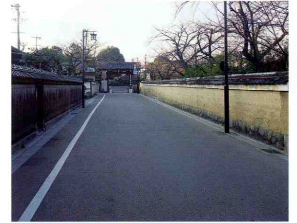
団栗通りから安井北門通りへと連なる道は自然色アスファルト舗装とし、周辺の景観と調和させた。
