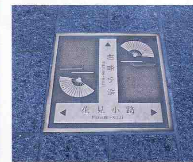
歩行者の安全性を確保する為、歩車道の舗装に用いる石の大きさを換え、歩車道のイメージ的な分離を図った。また、バリアフリーに配慮し、路面の凹凸を出来るだけ少なくし、目地を狭くすることで誰もが歩きやすい道とした。
