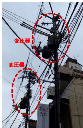
写真4-1 電柱に共架された変圧器等
