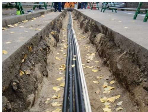
写真5-2 直接埋設方式の実験状況 (東一条通)
