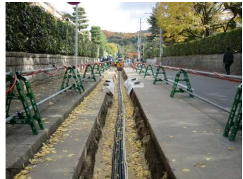
写真6-6 ケーブル埋設状況
