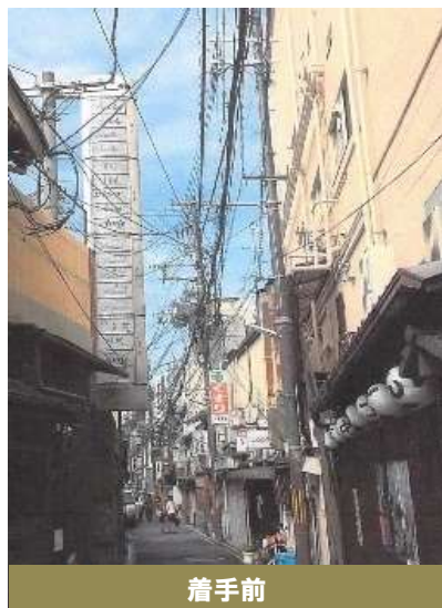
写真5-4 電線の密集状態の解消（弥栄緯5号線：東大路通～花見小路通）
