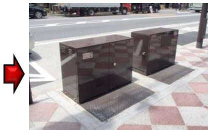
写真4-2 地上機器設置事例
