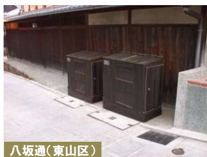
写真5-3 地上機器の民有地への設置事例
