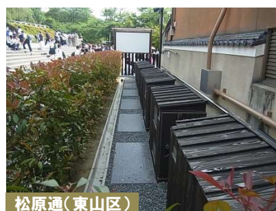
写真5-3 地上機器の民有地への設置事例
