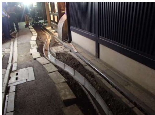
写真5-1 小型ボックス活用埋設方式の事例 (先斗町通)
