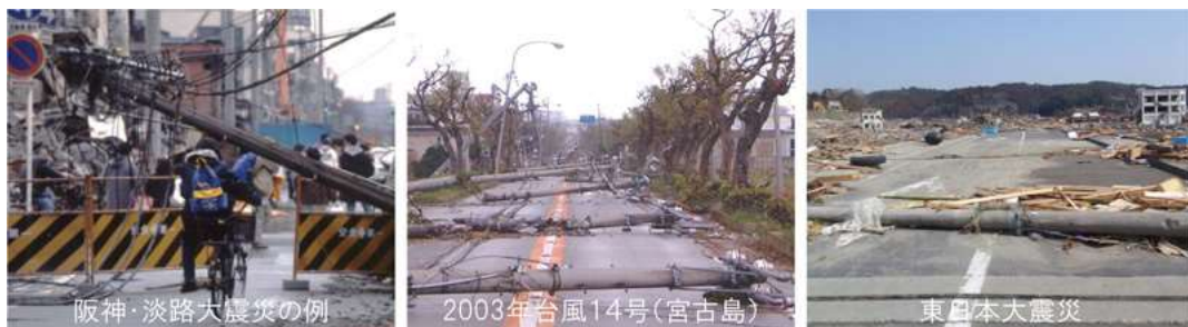
写真3-2 災害による電柱倒壊事例 (出典：国土交通省HP)
