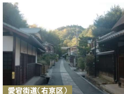
写真3-4 裏配線方式による整備事例
