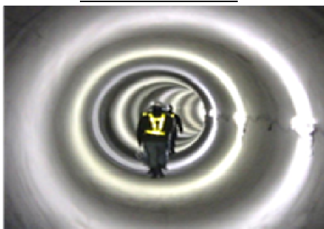
完成したトンネル
