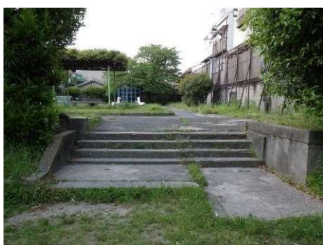
公園全体の老朽化
