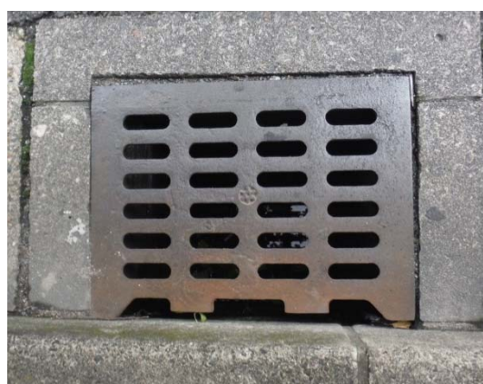
雨水枡蓋（整備後）
