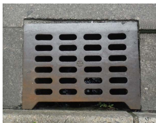
雨水枡蓋（整備前）
