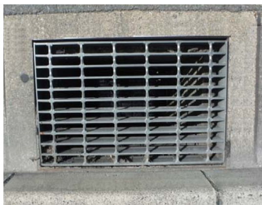
グレーチング蓋（整備前）
