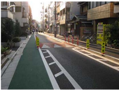
写真II-12 車道部分にハンプを設置しハンプの両側に ゴム製ポールを設置した事例
