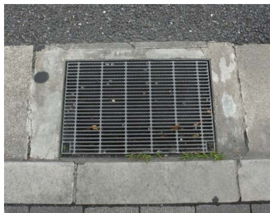
グレーチング蓋（整備後）
