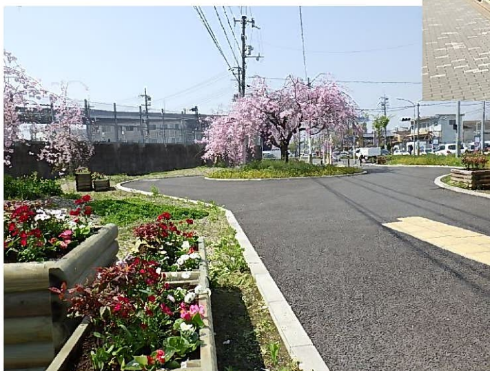
久世橋通（新町交差点）（H 2 6）
