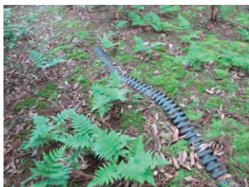
○ポンプ施設と表土の流失により露出した電線管
