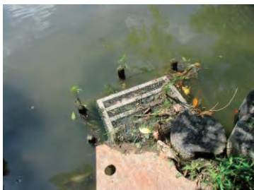
○ポンプ施設周辺に溜まる落ち葉
