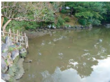
○ひょうたん池護岸石根入れ部の露出
