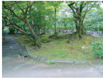
○園路沿いの樹木根上り
