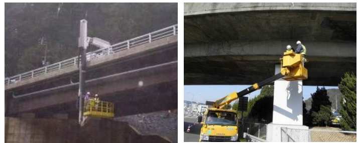
図 4.1 定期点検の様子
