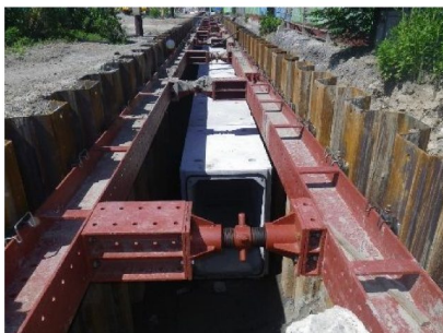
水路の設置状況
