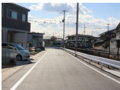
区画道路33号線 (府道京都守口線方面を望む)
