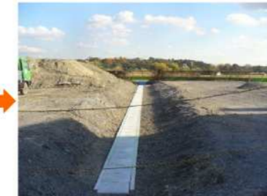
【施工中】横大路公園通整備工事
