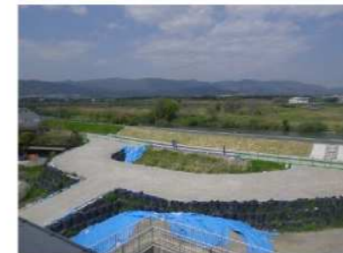
【施工前】桂川堤防復旧工事 【施工前】広場整備工事
