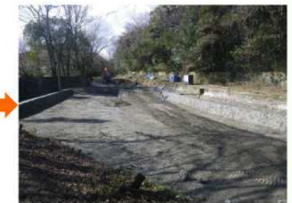
【施工中】承水路整備工事
