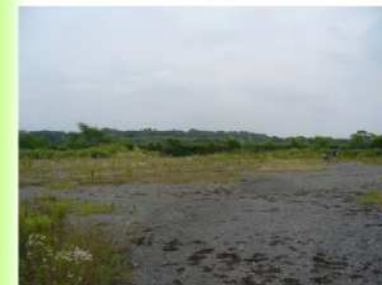
【施工前】横大路公園通整備工事
