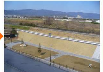
【施工中】桂川堤防復旧工事 【施工中】広場整備工事
