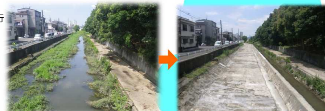
地盤改良工事 施工前
