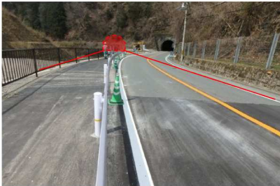
写真②（第2トンネル）
