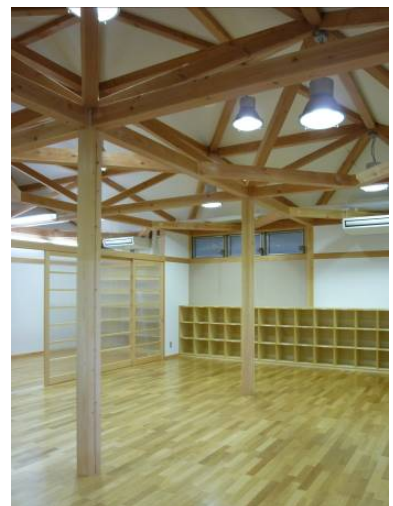
柱・梁等の構造材や壁・床・建具等の内装材、ロッカーに木材を使用
