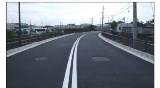
完成した道路（横大路淀線）
