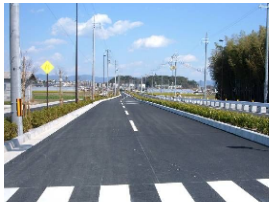
伏見向日町線（東工区）完成
