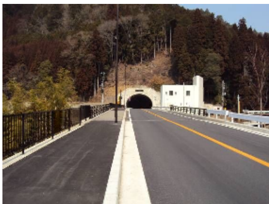
京北トンネル開通
