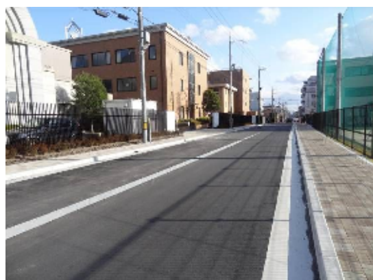
西小路通工事完成
