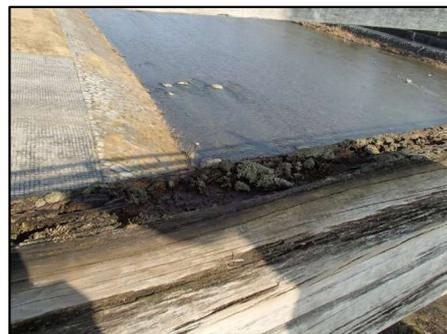
三条大橋の木製高欄（木材の腐食、ひび割の状況）
