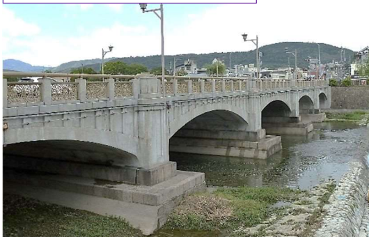
七条大橋（大正2年建設）
