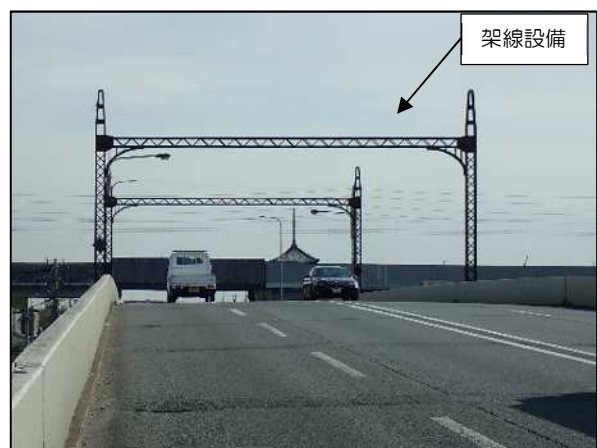
現在の架線設備
