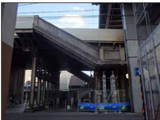
撤去前の懐かしい階段
