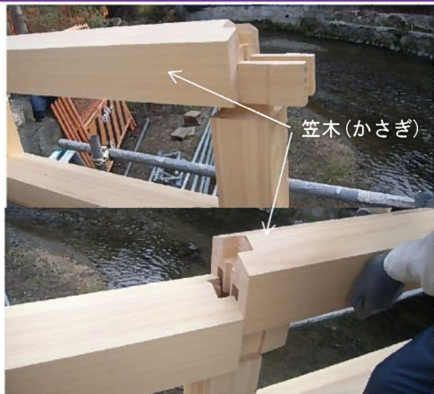
更新工事中の巽橋
