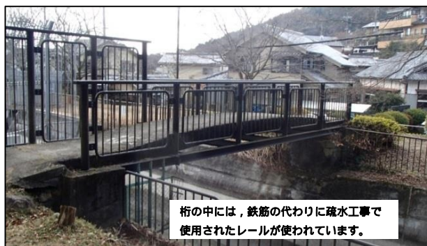
写真 第11号橋(京都市山科区) 完成年月: 明治36年(1903年) 国指定史跡
