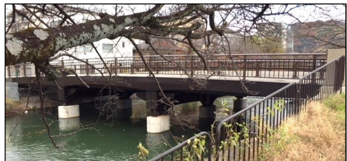
工事完了後の熊野橋
