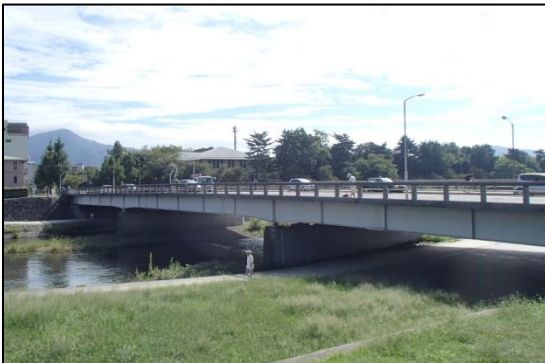
↑北山大橋（昭和37年完成）
