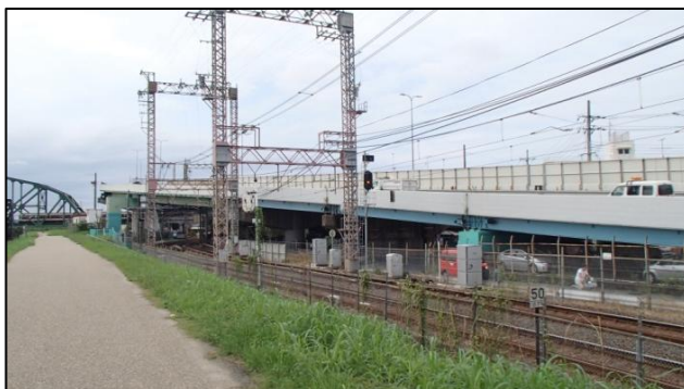
↑桃山高架橋（昭和45年完成）
