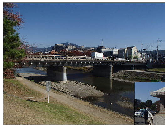
河合橋 (昭和13年架設)
