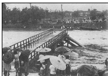
出町橋 (昭和26年) 昭和26年の災害で流出
