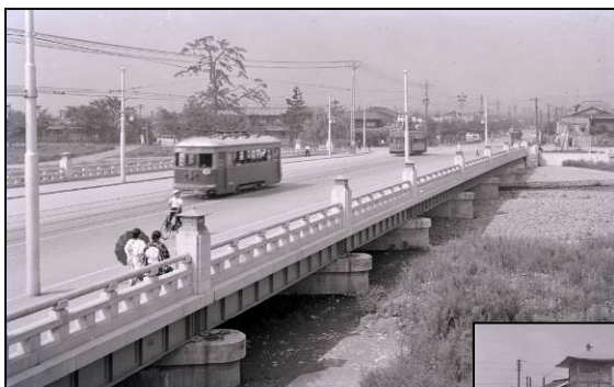
北大路橋 (昭和8年架設)
