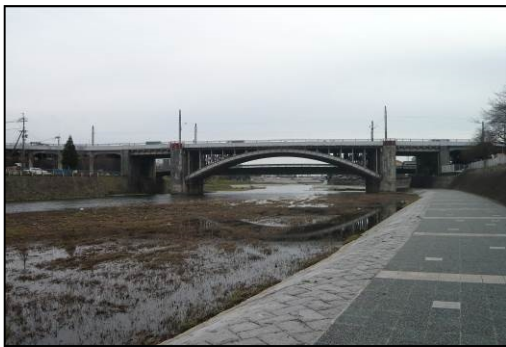
九条跨線橋 (昭和12年架設)
