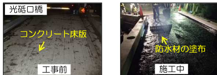
↑アスファルト舗装を一旦撤去し、コンクリート床版との間に防水材を塗布しました。
