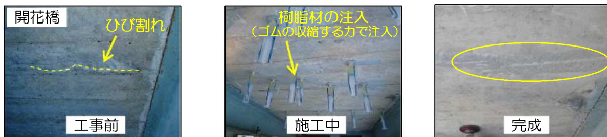
*コンクリート床版の裏面の写真
