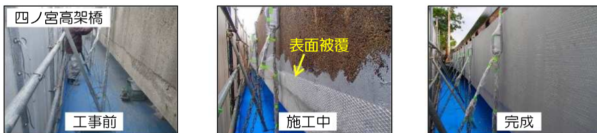
↑コンクリート製壁高欄の側面などに、メッシュ状のネットを張り、表面を被覆しました。
