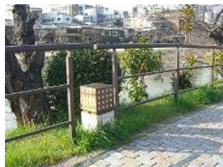
石と真鍮を組み合わせた フットライト。 防護柵の間に設置している。
