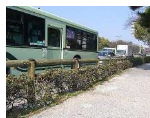
間伐材を用いた横断防止柵 植栽と組み合わせることで 表情を和らげている。
