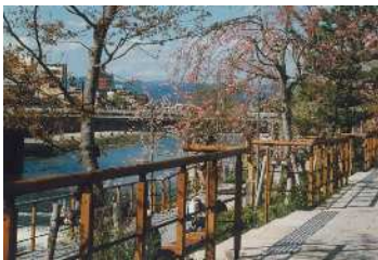
鉄と木材を組み合わせたシンプルな構成の横柵型。
