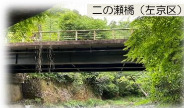
二の瀬橋（左京区） 工事が完了した橋りょう
