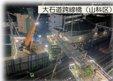
大石道跨線橋（山科区） 工事中の橋りょう
