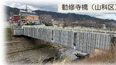
勧修寺橋（山科区） 工事中の橋りょう
