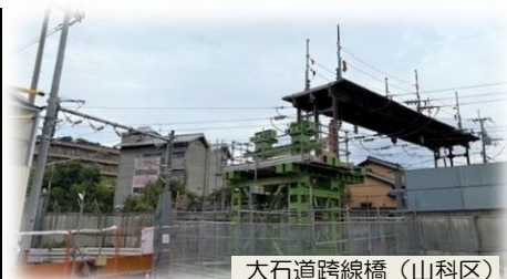
大石道跨線橋（山科区）
