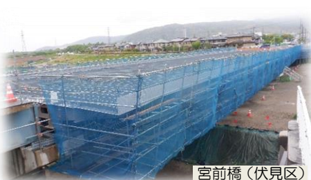
宮前橋（伏見区）
