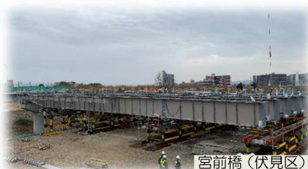
工事中の橋りょう
