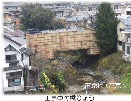
市原橋（左京区） 工事中の橋りょう
