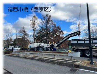
工事中の橋りょう
