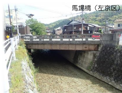
工事に着手した橋りょう
