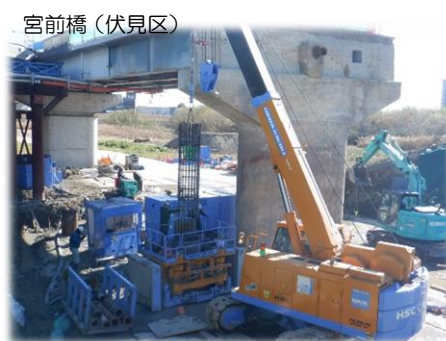
工事中の橋りょう
