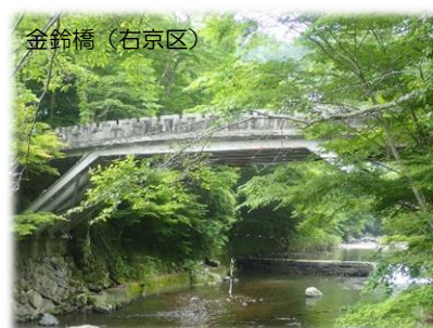
工事が完了した橋りょう
