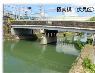
工事に着手した橋りょう
