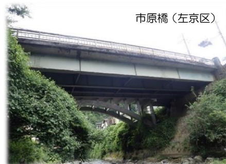
工事に着手した橋りょう
